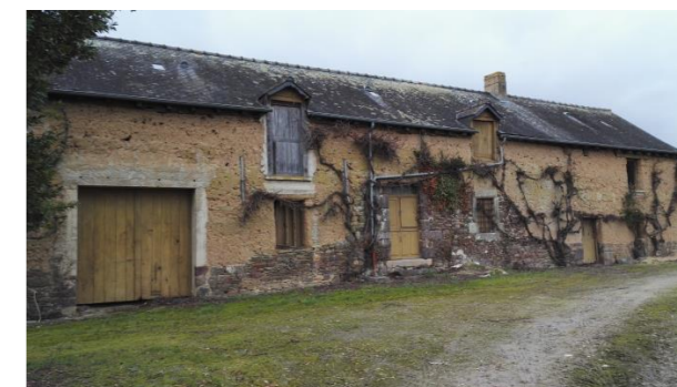
Longère agricole « La basse ville au manoir » dans le secteur sud du périmètre d'étude ayant un usage de stockage. Le projet prévoit l'aménagement d'un tiers-lieu dans cette longère en raison de son caractère central.
