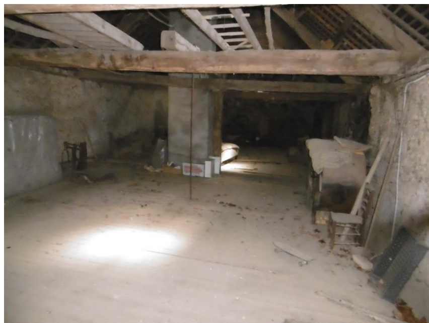
Figure 34 : Prise de vue des combles à l'intérieur de la longère – IAO SENN, 2018
