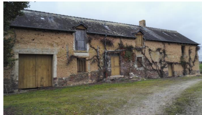
Longère agricole « La basse ville au manoir » dans le secteur sud du périmètre d'études ayant un usage de stockage
