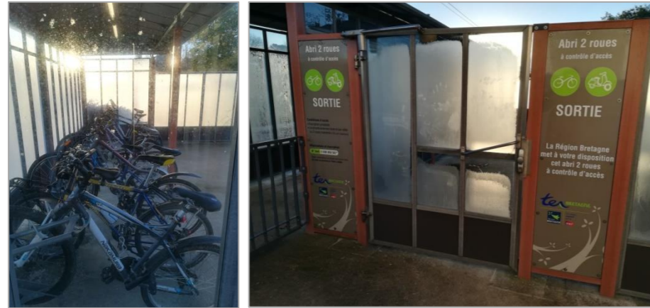
Figure 45 : Prise de vue du parking vélo couvert avec contrôle d'accès à proximité de la gare - CDVIA, 08/02/2018
