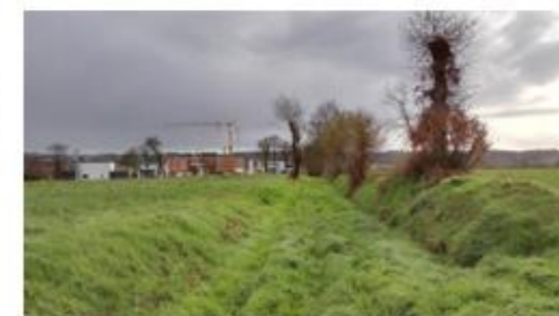
Vue sur le chemin creux classé EBC au PLU sur la frange ouest et sur l'opération « Parc de la Touchère » porté par Nexity au sud du projet ZAC Bromedou.
