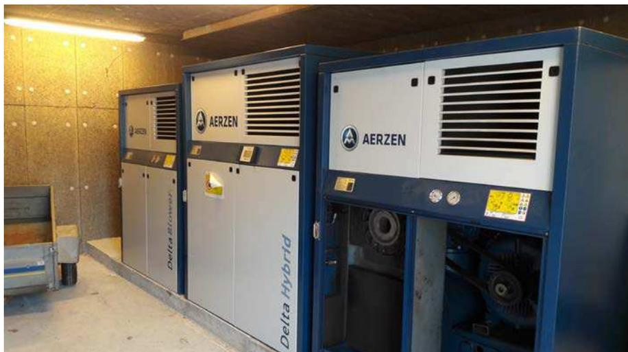
**Installation du surpresseur de secours en fixe : il était prévu initialement en caisse**
