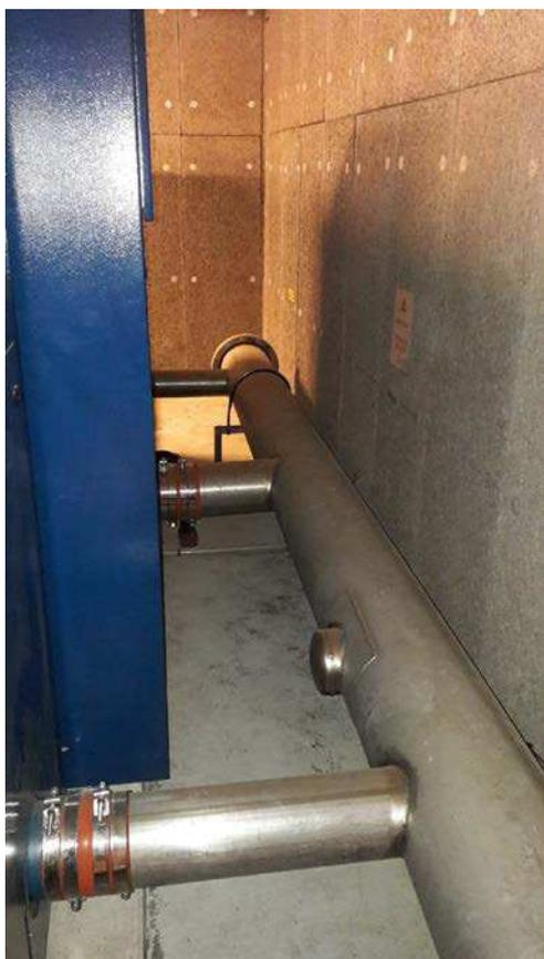
Modification hydraulique pour raccordement du surpresseur de secours, réalisation d'une dalle béton pour pouvoir
