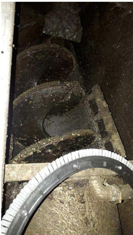
**Remplacement des brosses de la vis du dégrilleur rotatif.**
