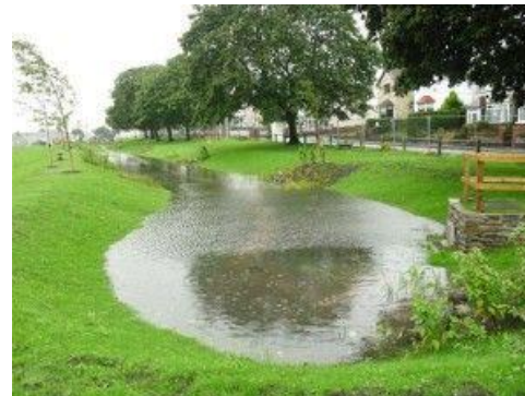
Exemple d'aménagement d'ouvrages de gestion des eaux de pluie, intégrés dans le paysage
